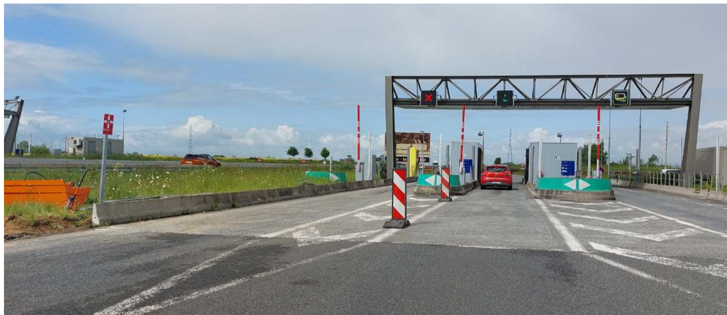
Les barrières de péages traditionnelles vont disparaître sur l'autoroute A13, au profit de structures qui n'imposeront plus aux automobilistes de s'arrêter. Ce sera notamment le cas à la sortie de l'agglomération de Caen, à Cagny. Maxence GORREGUES
