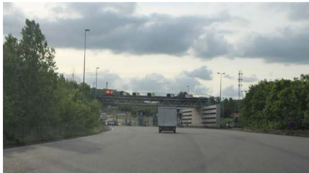
Avec son projet d'autoroute en flux libre, la Sanef veut enlever l'ensemble des points de péage sur les 210 kilomètres de l'A13 et de l'A14, comme ici à l'échangeur d'Incarville, qui est le premier chantier. La Dépêche de Louviers - Pierre CHOISNET
