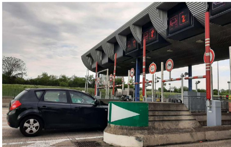
La barrière de péage de Montesson est l'un des quatorze sites du réseau A13/A14.
