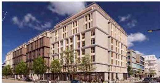
Projet "Delage", reconversion d'un site au passé industriel, acquis par Hines auprès d'Interconstrucor en septembre dernier, en une résidence étudiante à Courbevoie.
